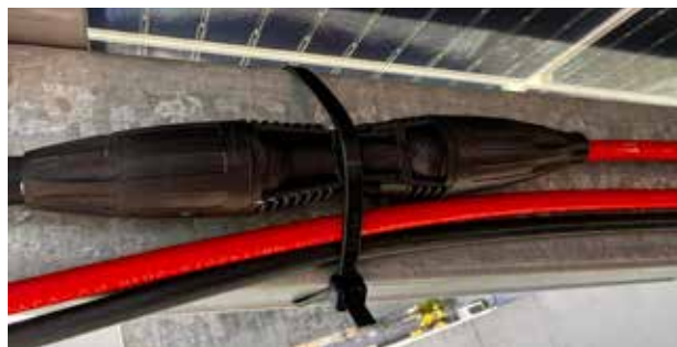
Hình 61: Gia cố tăng thêm kẹp cuối và buộc gọn đầu nối MC4
