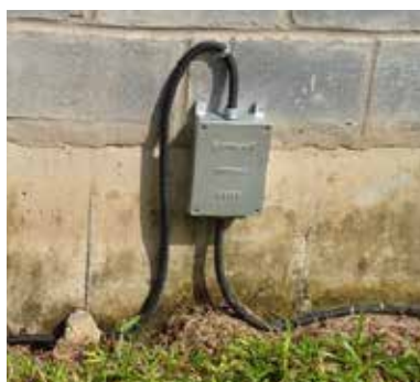
Hình 8: Dây tiếp địa nối vào khung giá đỡ, hộp kiểm tra tiếp địa và bãi tiếp địa
