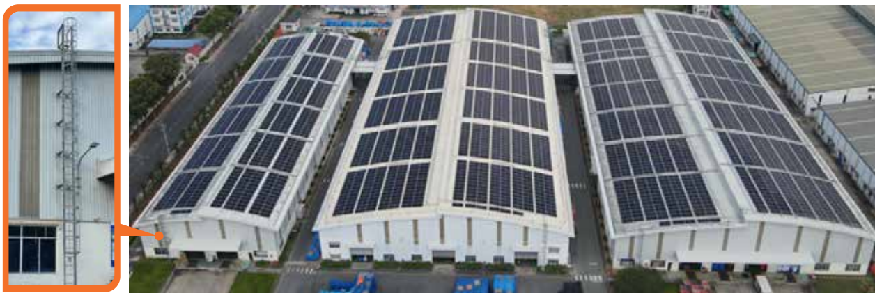
Hình 56: Vị trí lối tiếp cận lên mái và thang lên mái
