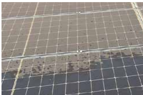
Hình 26: Tấm quang điện bị bám bụi bẩn
