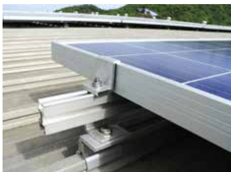
Hình 3: Khung giá đỡ tấm quang điện
