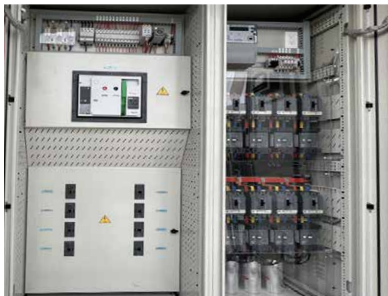
Hình 6: Hình ảnh bên ngoài và bên trong tủ phân phối AC
