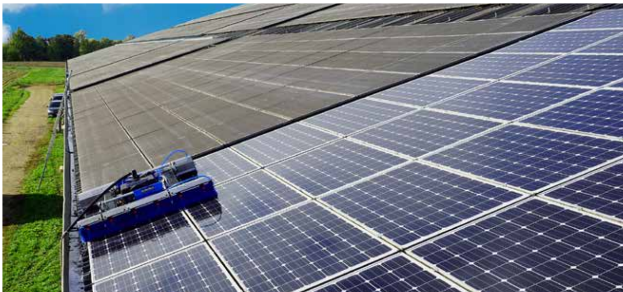
Hình 64: Tấm quang điện trước và sau khi được vệ sinh bằng hóa chất tẩy rửa phân hủy sinh học chuyên dụng 7
