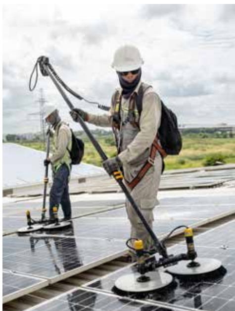
Hình 27: Vệ sinh tấm quang điện
