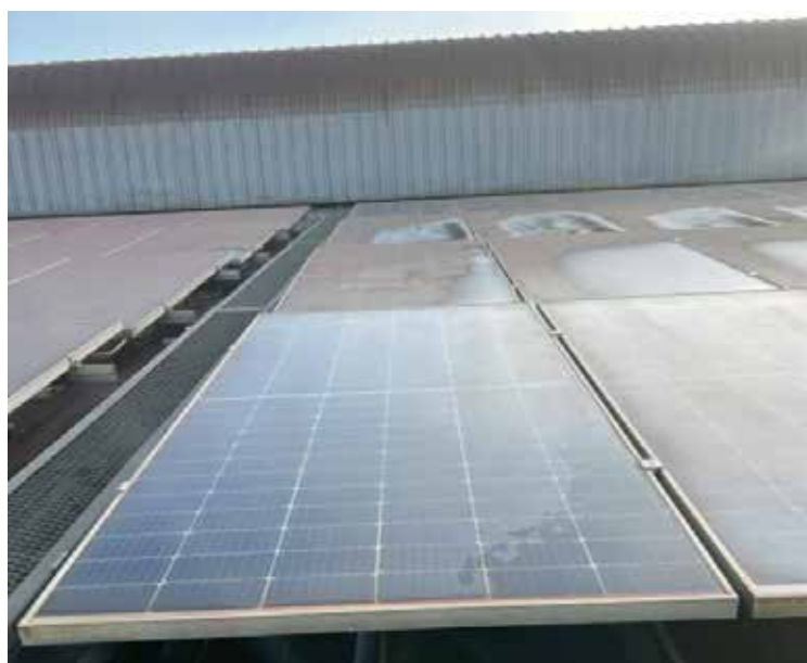
Hình 65: Tốc độ bám bụi giảm rõ rệt sau khi vệ sinh tấm quang điện bằng hóa chất tẩy rửa phân hủy sinh học chuyên dụng
