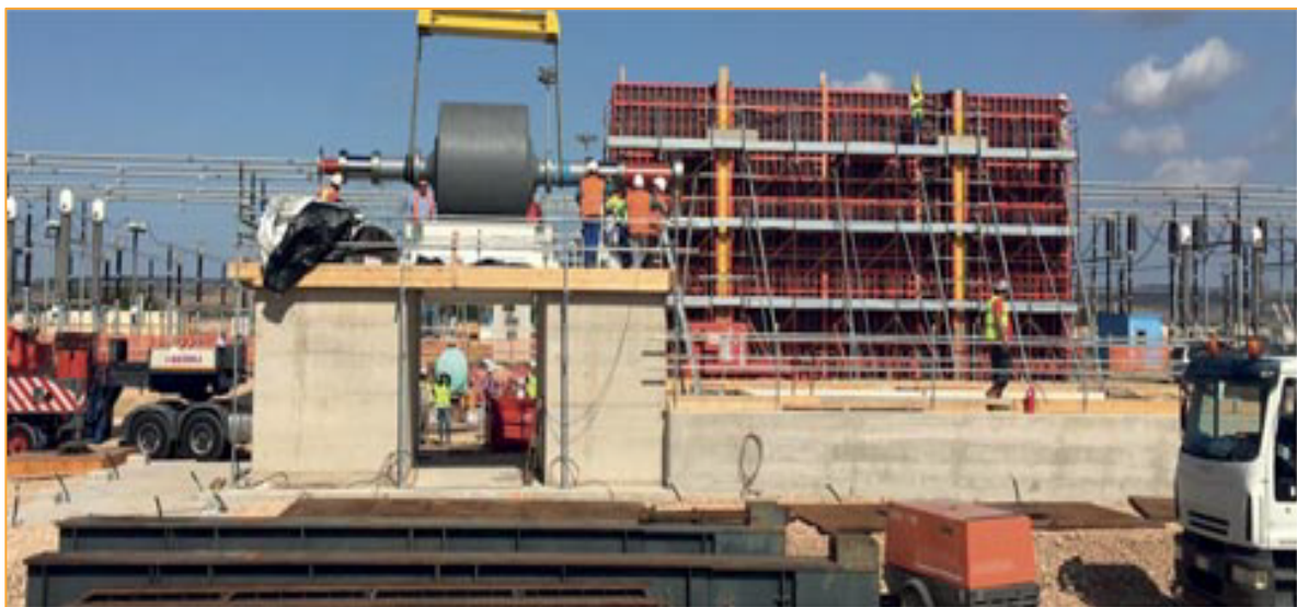
Hình 5.1 Lắp đặt trạm máy bù đồng bộ tích hợp bánh đà. Nguồn hình ảnh: Biondi and Priano, 2022.
